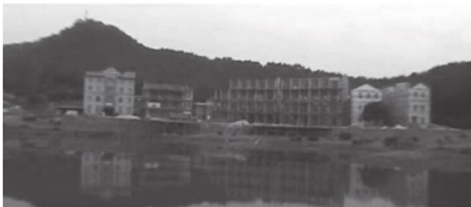
中環全景搭建中
